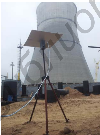
Рис. 3. Измерение низкочастотных полей при помощи штыревой антенны на площадке
