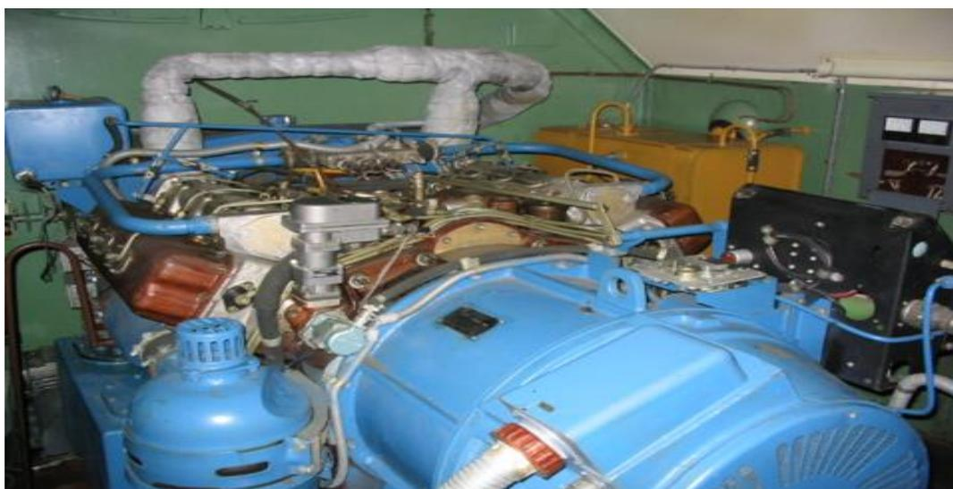
Рис. 6.5. Агрегат питания ДГМ-60-Т/230-Ч400
