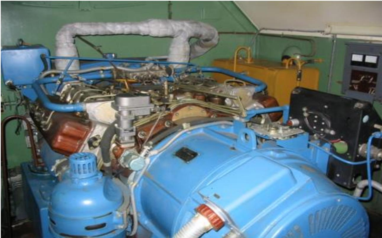
Рис. 7.5. Агрегат питания ДГМ-60-Т/230-Ч400
