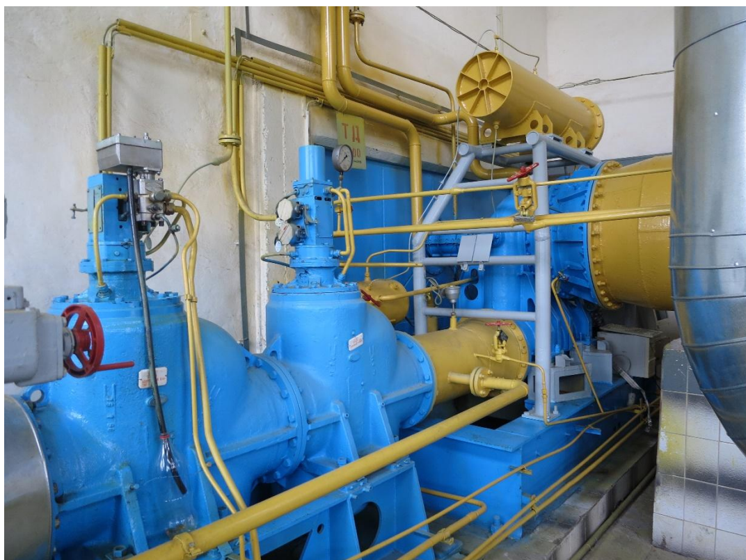
Рисунок 5.1 – Турбодетандер ДГА
