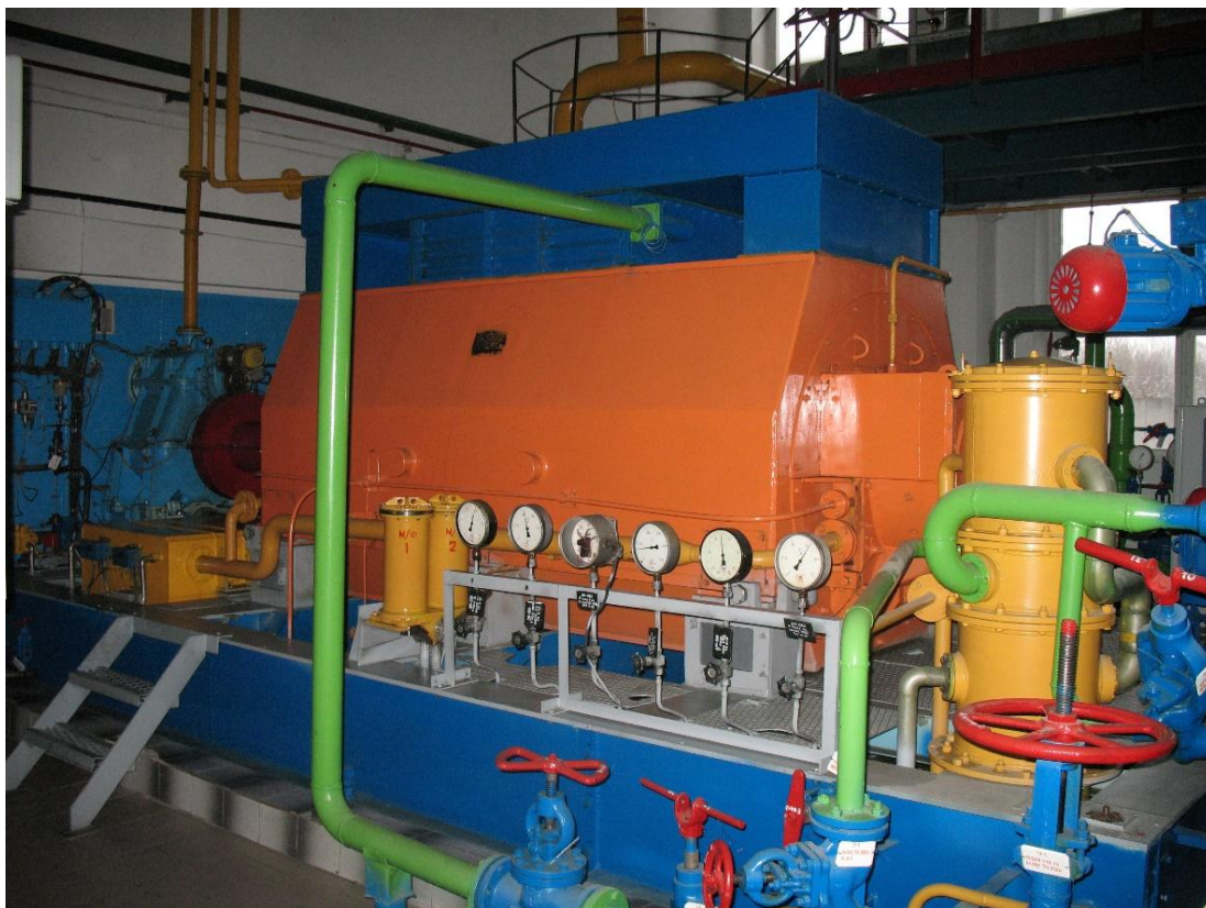
Рисунок 5.2 – Редуктор и генератор ДГА
