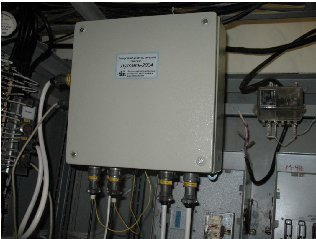
Рисунок 5.4 – Блок аналоговой коммутации виброизмерительных каналов и низкочастотной фильтрации
