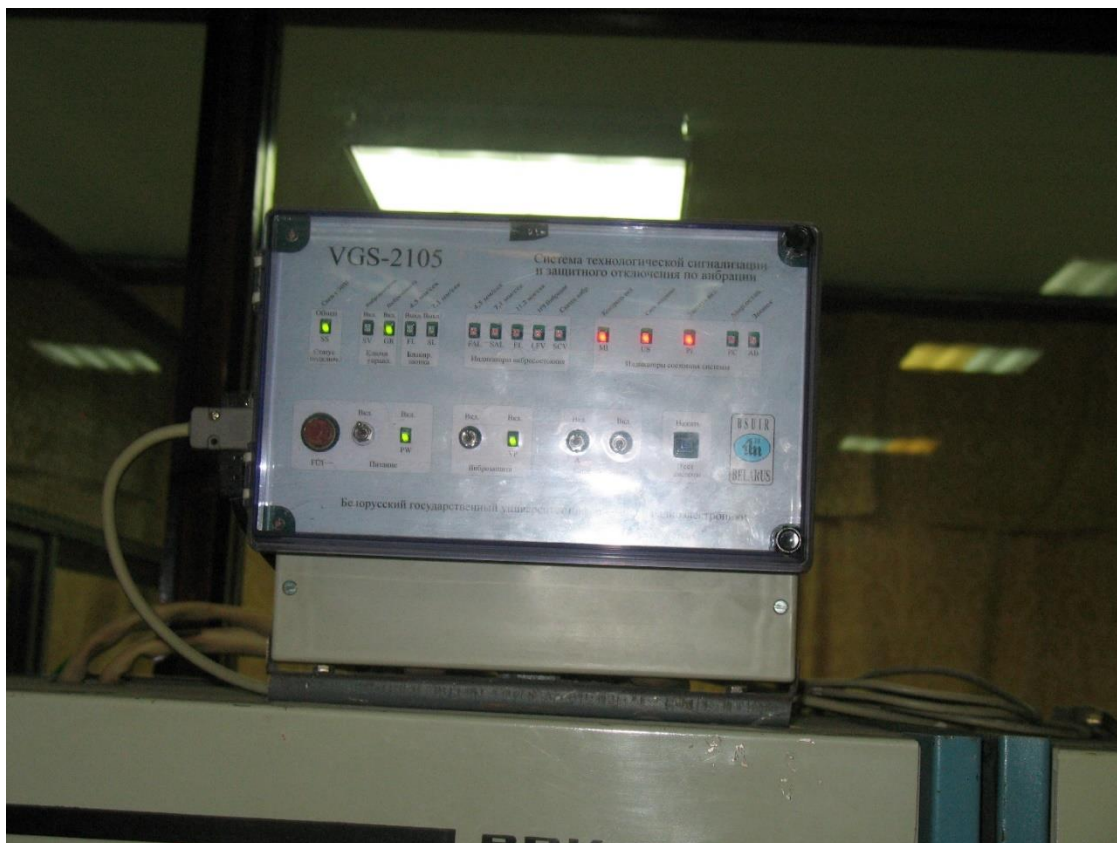
Рисунок 5.6 – Блок реле для управления сигнализацией и защитным отключением
