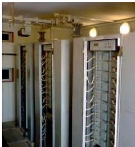
Рисунок 3 - Передатчик ТРЛК «Сопка-2»
