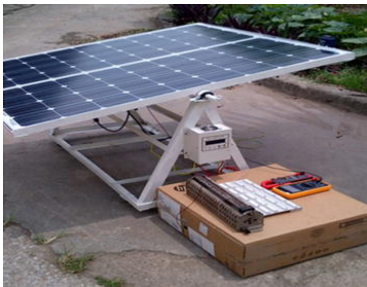
Рисунок 2. Установка солнечной панели DS-100M
