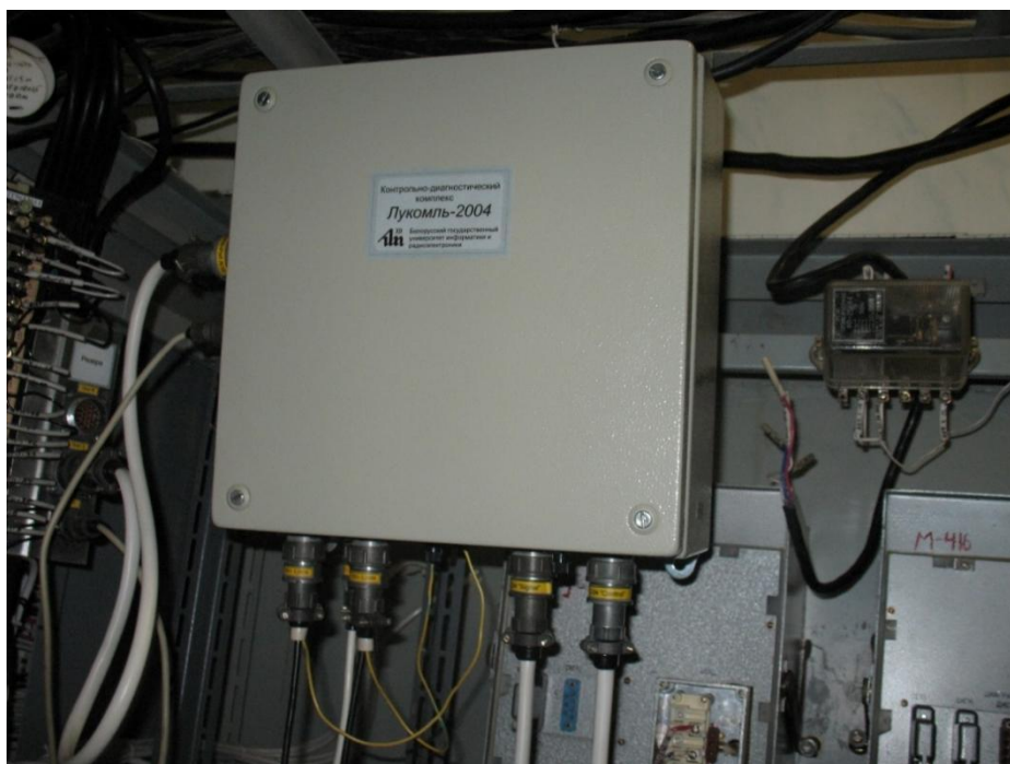
Рисунок 4. Блок аналоговой коммутации виброизмерительных каналов и низкочастотной фильтрации
