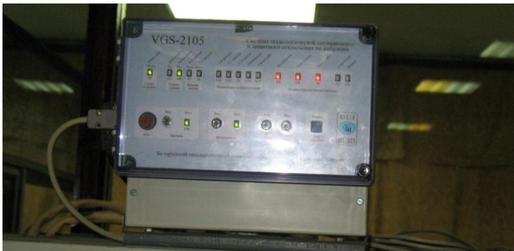
Рисунок 6. Блок управления сигнализацией и защитным отключением
