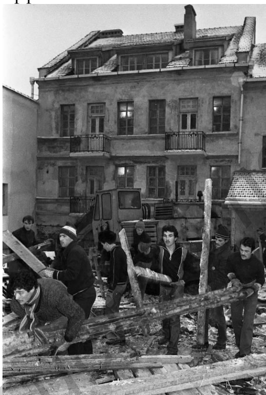
Члены ССО «Авангард» МРТИ на реставрации Троицкого предместья г. Минска. Декабрь 1985 г.
